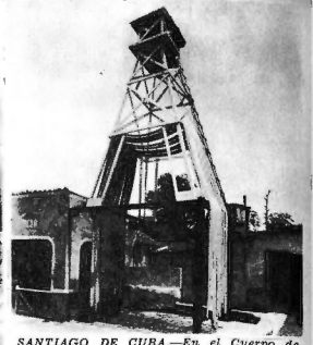
SANTIAGO DE CUBA. —En el Cuerpo de Bomberos de esta ciudad tienen realizándose importantes obras de mejora. La foto muestra la torre construida para secadero provisional de mangueras; en el tope está instalada la sirena de alarma.
